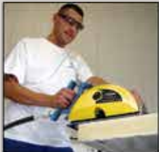
Sägt Sandwichpaneelen, Cuts sandwich panels,
